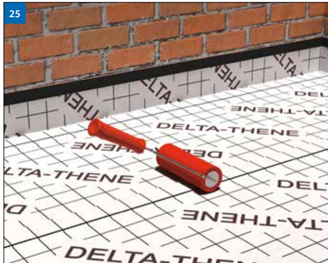
(Рис. 25) Все нахлёсты, примыкания и проходки тщательно прокатать роликом, не допуская образования воздушных полостей и пузырей.
