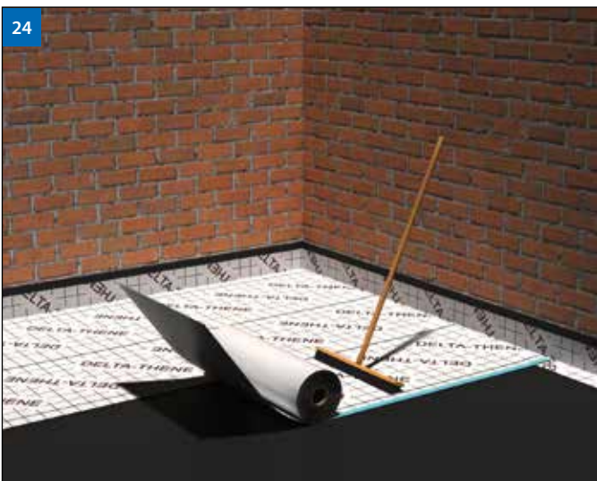
(Рис. 24) Следующий рулон уложить с нахлестом 10 см. Удалить с нижнего рулона защитную синюю полосу и проклеить зону нахлёста рулонов.
