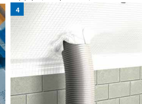
Вентиляционная проходка (Шаг 2 – нанесение 1-го слоя DELTA-LIQUIXX и армирующей ткани)
