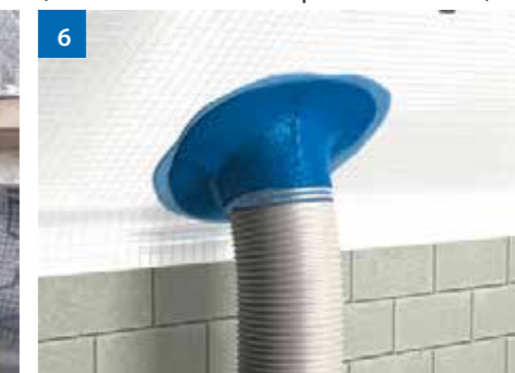
Вентиляционная проходка (Шаг 3 – нанесение второго слоя пасты)
