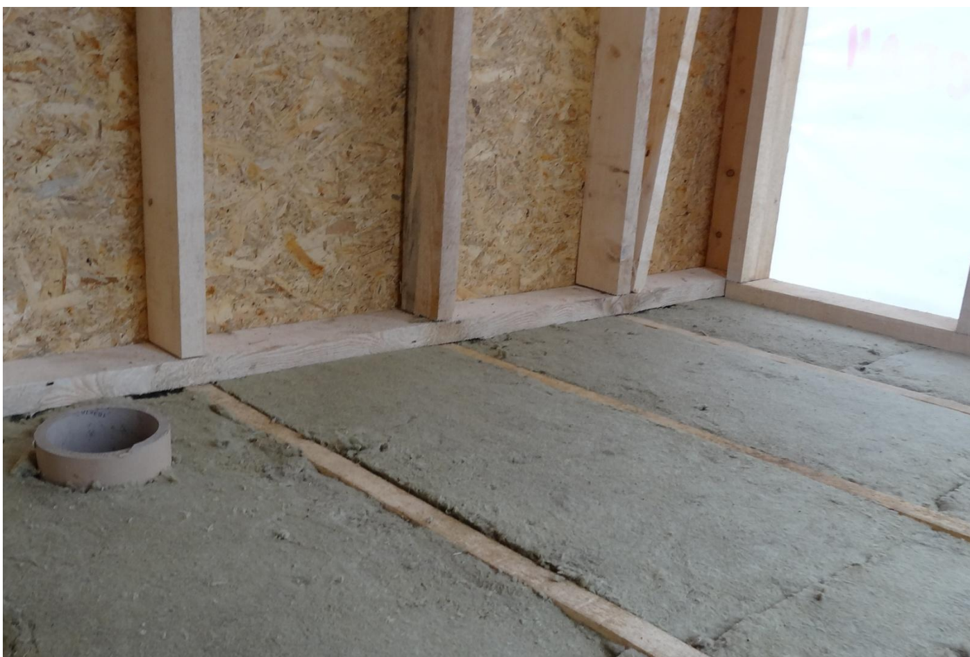
Изнутри помещения был смонтирован пароизоляционный слой.
